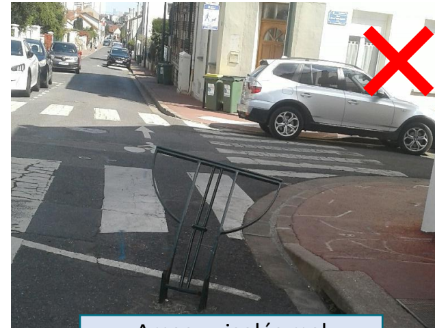
Arceaux isolés mal installés
