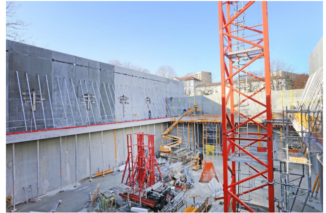
Décembre 2019 – Vue de l'avancement gros-œuvre depuis l'intérieur du futur théâtre
