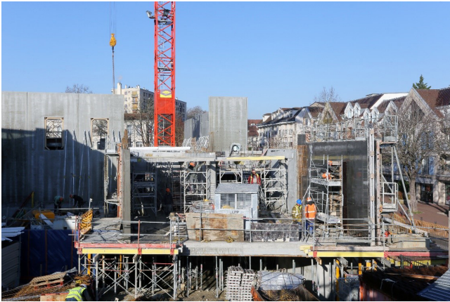
Décembre 2019 – Vue de l'avancement gros-œuvre depuis l'intérieur du futur théâtre
