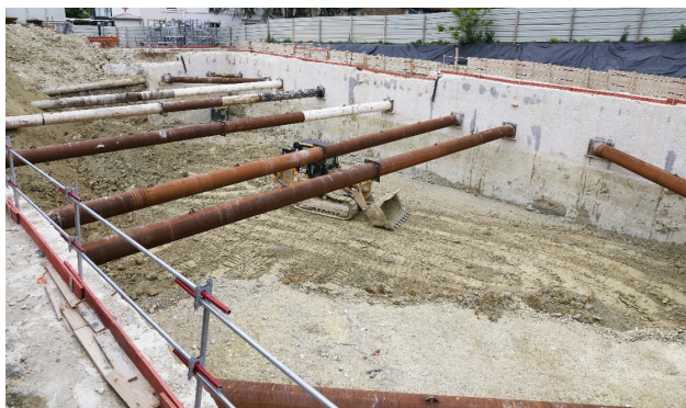
Mai 2019 – Terrassements et pose des buttons
