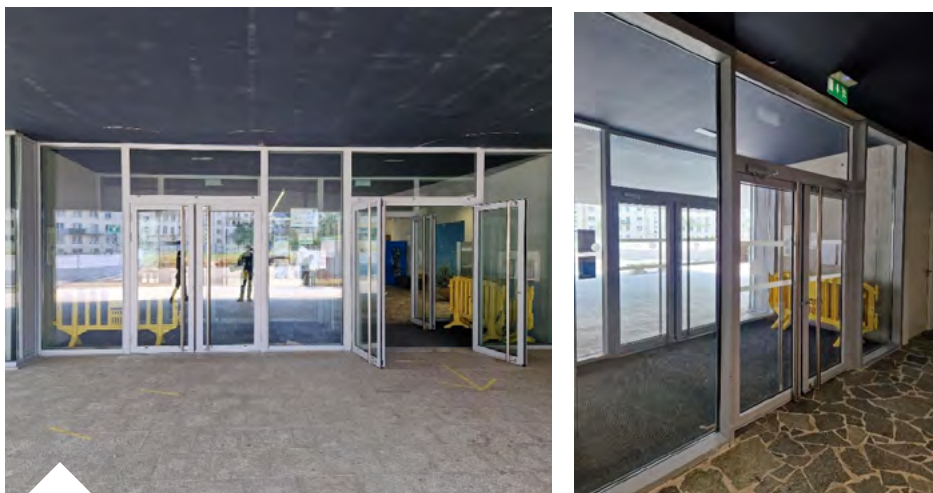
Remplacement des portes du sas d'entrée (53 800 € TTC)
