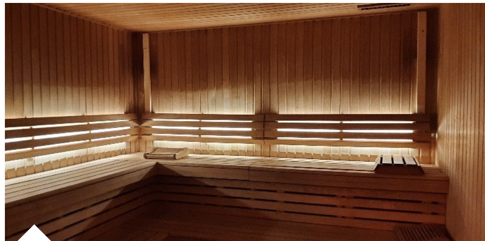
Remplacement de l'éclairage du sauna (1 930 € TTC)
