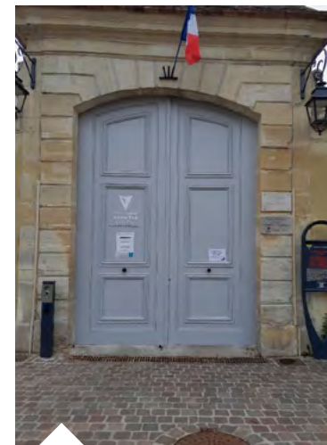
Réfection de l'interphonie des Espaces d'Attente Sécurisés (3 900 € TTC)
