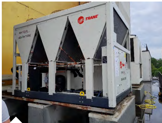
Remplacement d'un groupe froid (111 300 € TTC)
