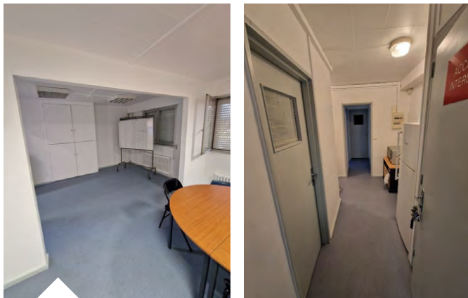
Remise en peinture et remplacement du revêtement de sol dans la salle de réunion et la zone administrative (20 717 € TTC)
