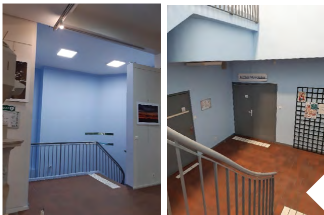
Remise en peinture de l'escalier desservant la salle Elsa Triolet en sous-sol (15 292 € TTC)
