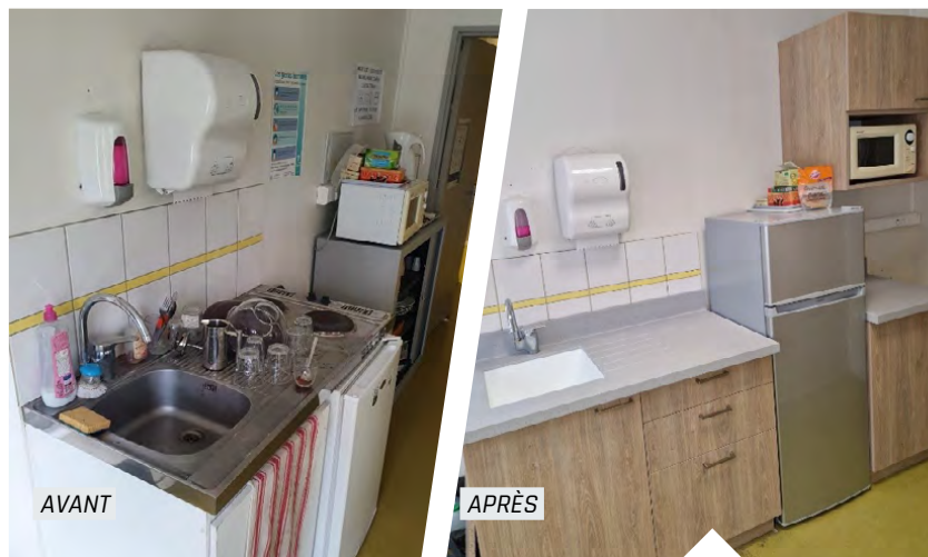
Réfection de la cuisine du personnel, y compris équipements (11 183 € TTC)
