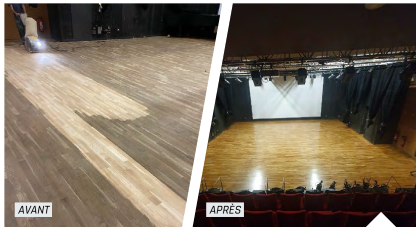
Réparation, ponçage et vitrification du parquet de la scène de l'auditorium (7 776 € TTC)
