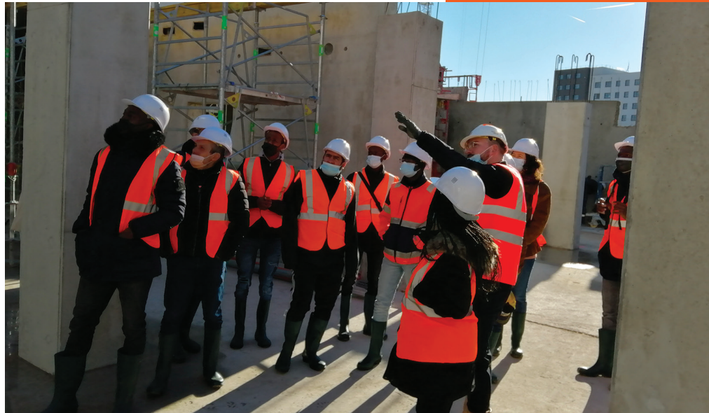
Visite du chantier de la construction du nouveau siège de Lidl à Châtenay-Malabry.
