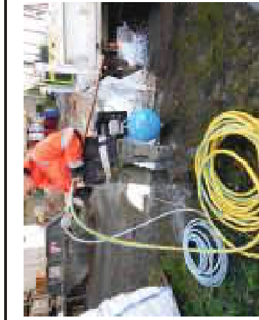
● Système de pompage pour développement des piézomètres
