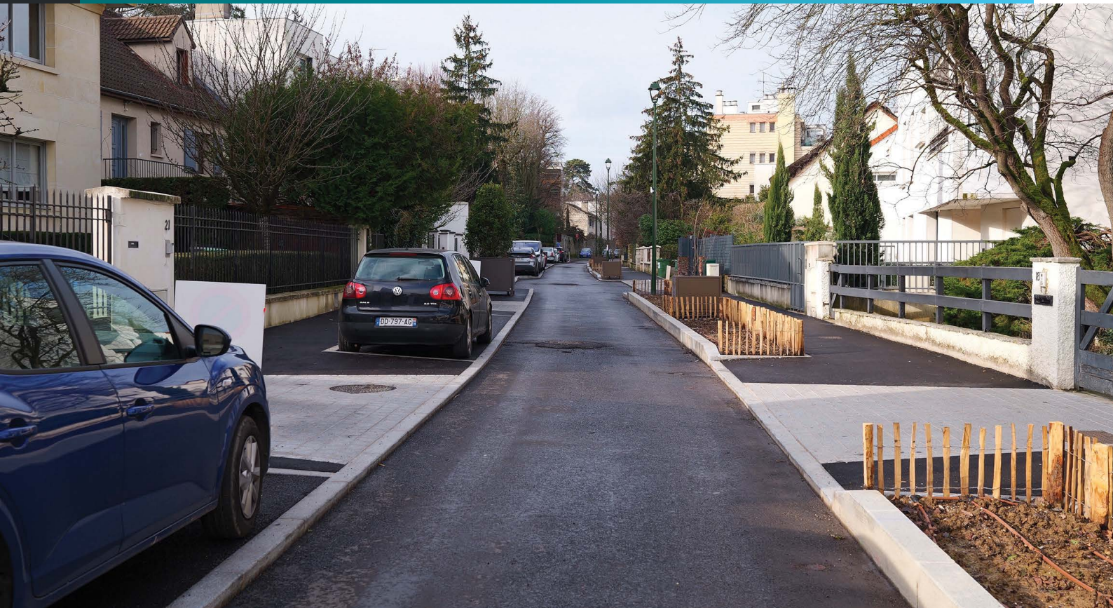
A Bourg-la-Reine, le nouvel aménagement de la rue Auguste Demmler
