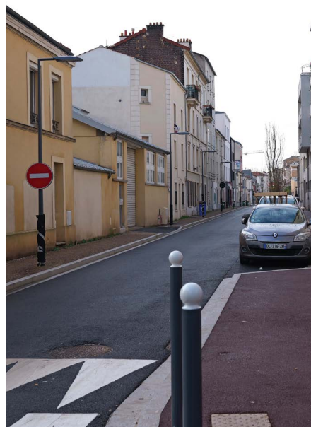
Les travaux de la Vélo-rue à Malakoff en voie d'achèvement
