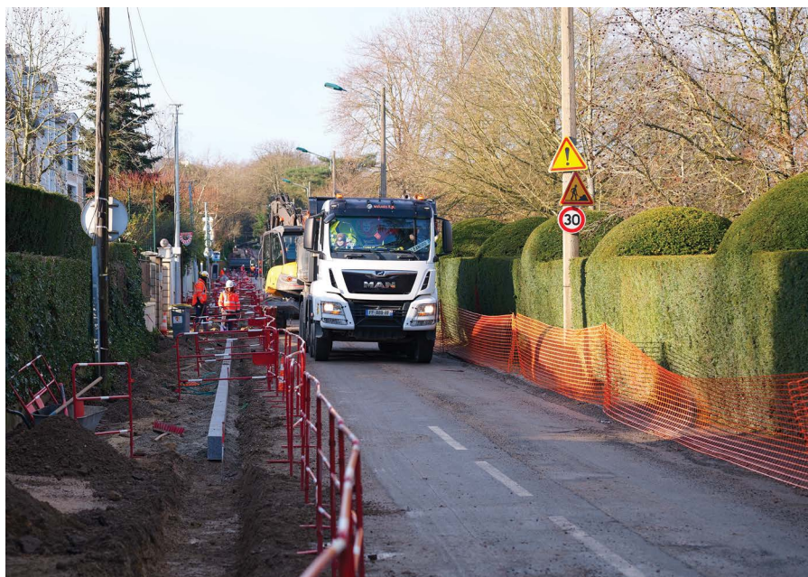
Les travaux du réaménagement de l'avenue Jean Jaurès à Châtenay-Malabry
